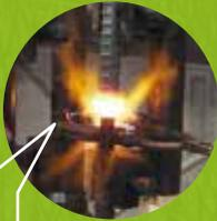
ガス圧接は鉄筋を加熱・加圧し、固体のまま接合して母材と同じ強度を得る方法です。アセチレンガスに代わり天然ガスを使用することで、環境負荷の低減が図れます。
